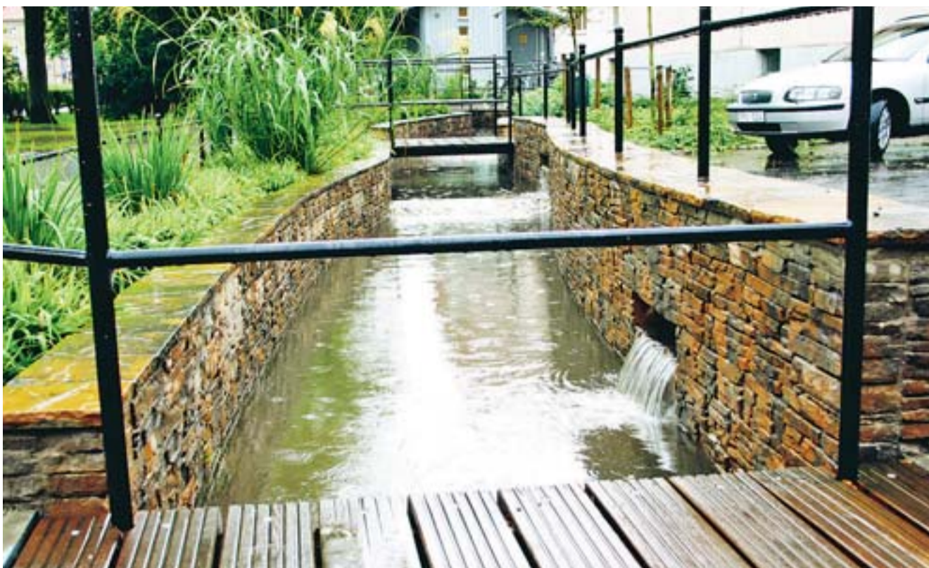
I dag präglas Augustenborg av det öppna dagvattensystemet. Den tiden är förbi när områdets källare översvämmades vid kraftiga regnväder.
